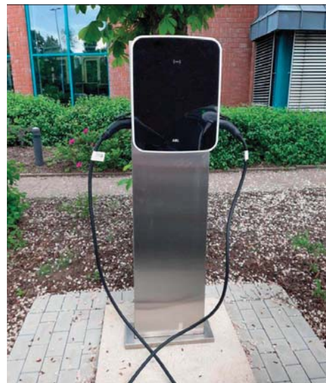
Ladesäule für Dienstfahrzeuge auf dem Wuppermannshof
