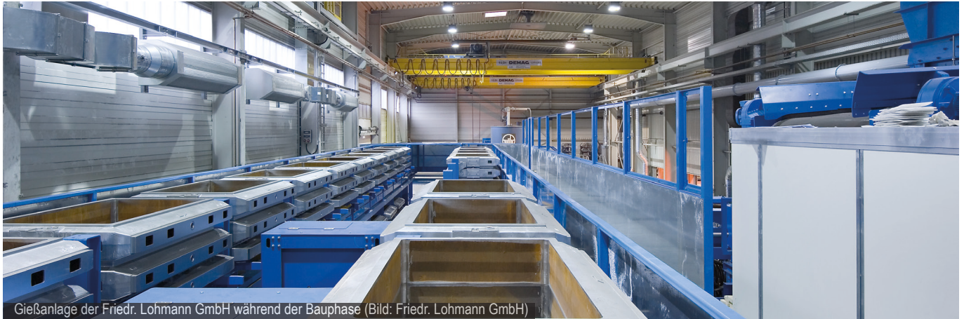
Gießanlage der Friedr. Lohmann GmbH während der Bauphase (Bild: Friedr. Lohmann GmbH)
